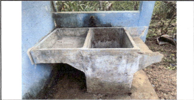
Foto 7: Pila quebrada.
