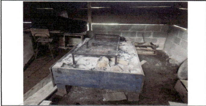
Foto 9: Cocina en malas condiciones sin mesa de trabajo adecuada.
